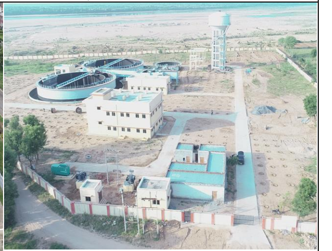
16 MLD STP, Tonk
