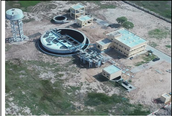
4 MLD STP, Tonk
